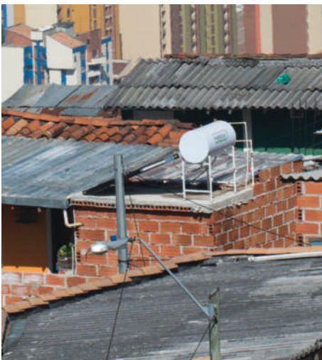
Vivienda con calentador solar
