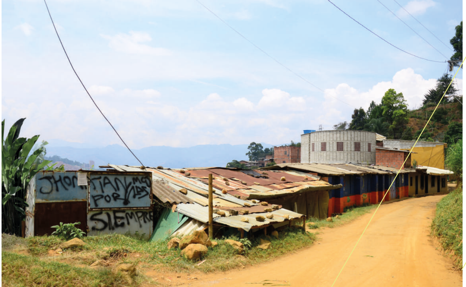
Proyecto de reasentamiento de vivienda - Antes / Polígono Esfuerzos de Paz
