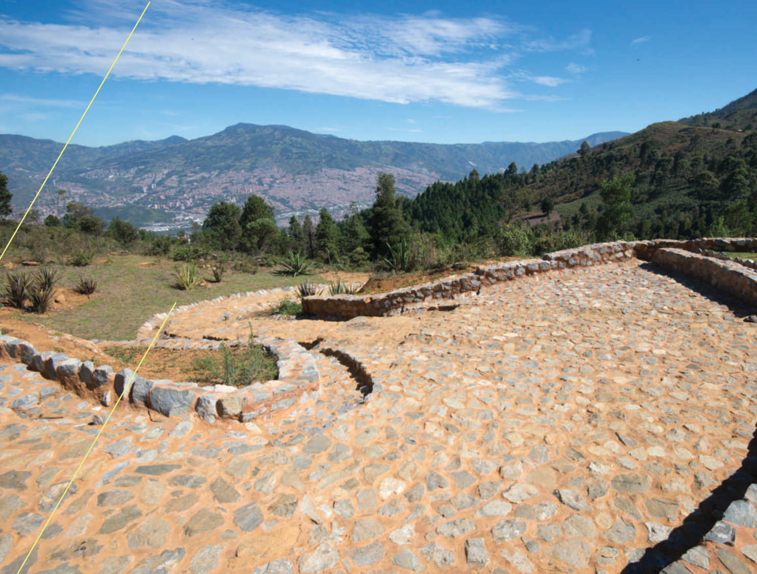
Camino en piedra hacia la cima del cerro Pan de Azúcar
