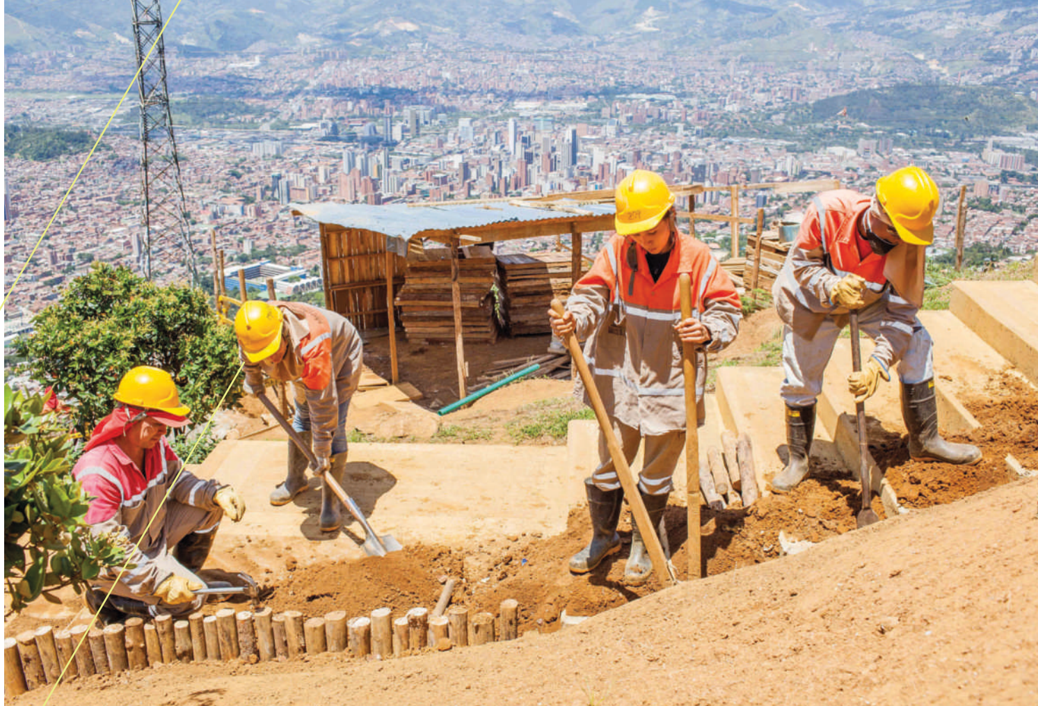
Construcción del Jardín Circunvalar
